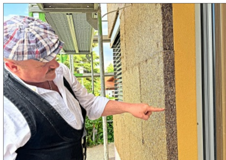
Sechs Zentimeter breit sind die Strohplatten, die auf 14 Zentimeter Holzfaserplatten aufliegen.
